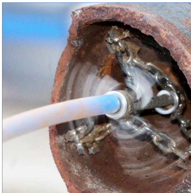
Čistenie potrubia pomocou čistiacej reťaze Spraypoxy.
