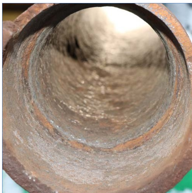
Potrubie musí byť pred nanesením nástreku Spraypoxy úplne čisté a suché.
